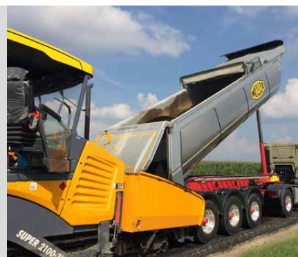
Pavimentación de asfalto: con la lona cerrada el asfalto mantiene su temperatura necesaria.
