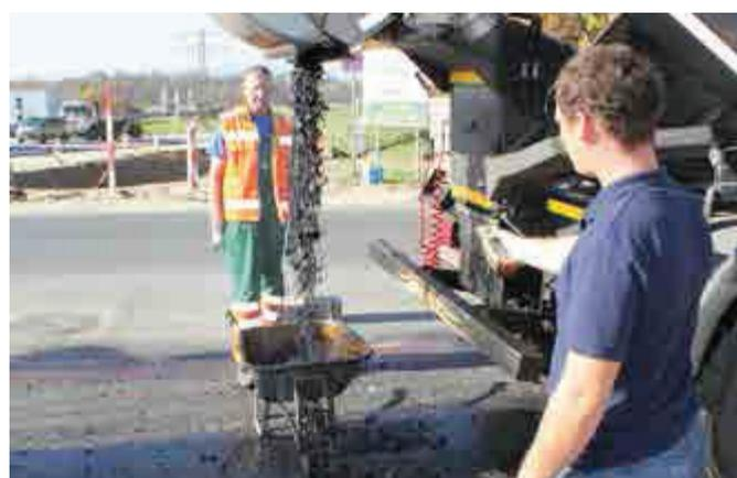
Feindosierung bietet die Möglichkeit, die Mischgutmenge dem jeweiligen Einsatz anzupassen. Um Treibstoff und Geld zu sparen, können alle Funktionen, wie z. B. Kippen, Bedienung von Auslaufschurre und Deckel – motorunabhängig - mit einem Elektroaggregat betrieben werden.
